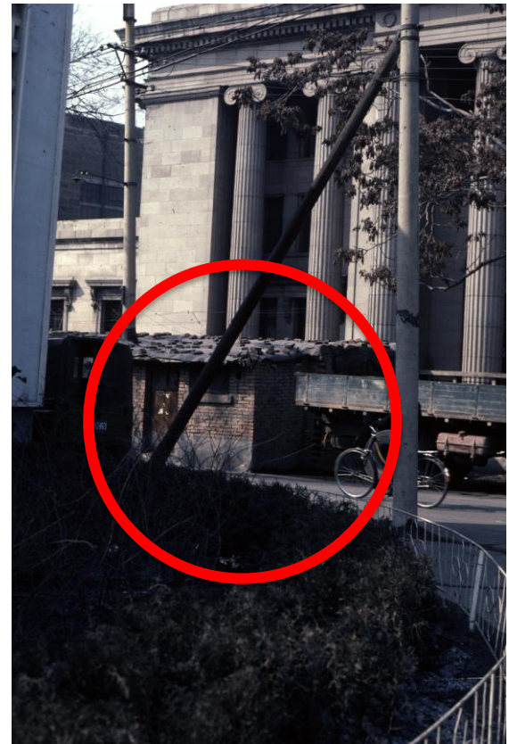
地震後の仮設住宅
